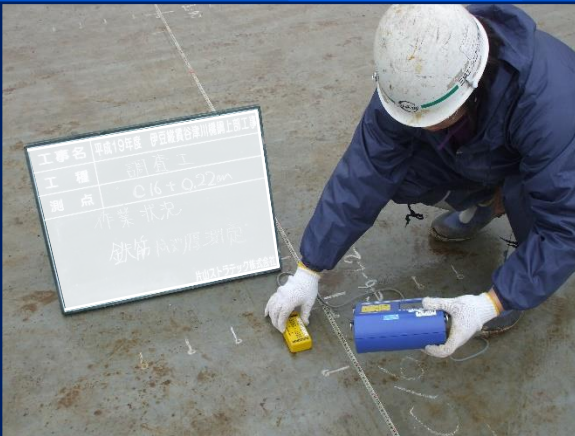
配筋調査(かぶり厚測定)
