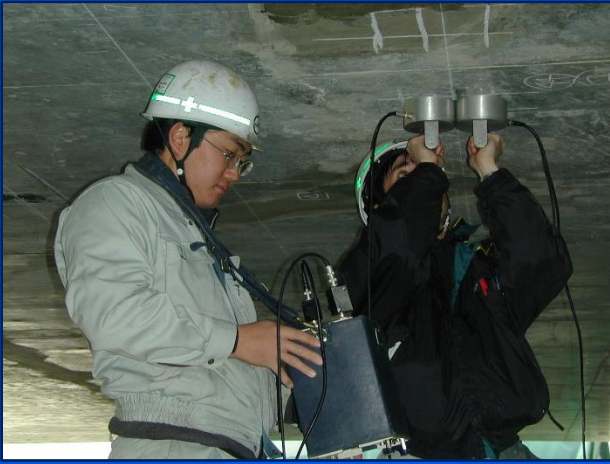
コンクリート厚さ測定
